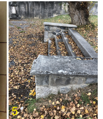
5 Réparation de l'em-marchement
