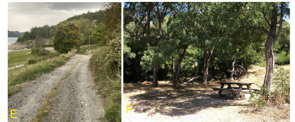
Décapage de l'ancien revêtement goudronné et remplacement par mélange terre pierre Remise en état du mobilier de pique-nique
