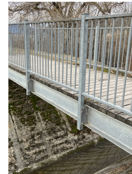
Principe de passerelle en métal et bois
