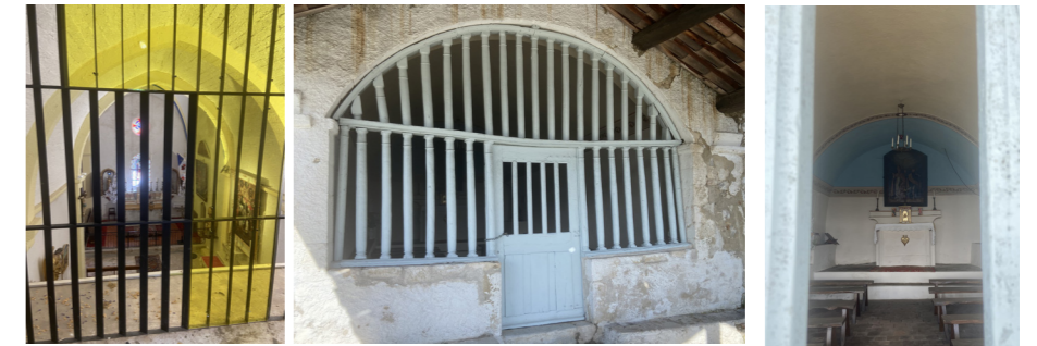
Autres exemples de systèmes anti intrusions laissant passer la vue avec grille en métal ou bois (entraînant la dépose et le remplacement de la porte existante)
